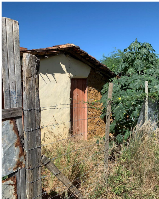
Legenda: Casa de taipa localizada no bairro Palmares, em Juazeiro.
